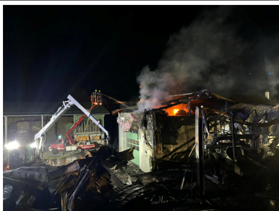
B3 Vollbrand einer Maschinenhalle – Dachöffnung mit unserem Steig
